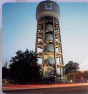
Risanamento strati corticali
