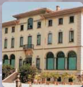
Sbarramento contro la risalita dell'umidità
