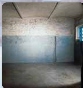
Impermeabilizzazione locali interrati
